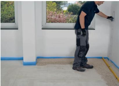
Dämme anhand des Meterrisses im Höhenprofil ausbilden. Schichtstärke min. 10 mm bis max. 100 mm.
