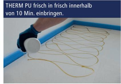
THERM PU frisch in frisch innerhalb von 10 Min. einbringen.
