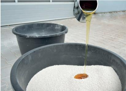
Gesamten Sackinhalt des Granulats in einen Mörtelkübel geben und den PU-Binder (1 Dose) vollständig hinzugeben.
