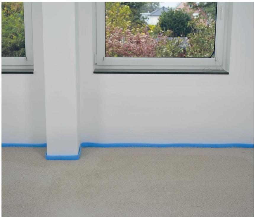
Nach 3 – 4 Stunden Trocknungszeit ist die Fläche begehbar und nach 24 Stunden belegbar. Achtung: CompactFloor THERM PU ist keine fertige Nutzschicht zur direkten Aufnahme von Bodenbelägen.
