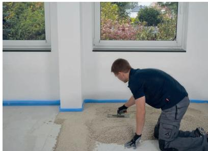
Fläche zwischen den Dämmen auffüllen und mit Kelle klopfend verdichten.
