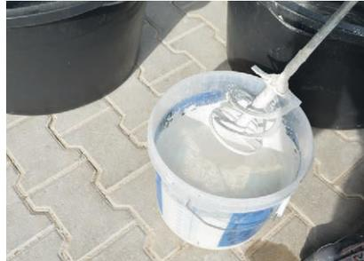
Wasser (3,75 Liter) und CE-Binder (1 Sack) in einem Eimer mit einem Rührwerk bei mittlerer Drehzahl verrühren.
