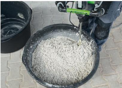
3 Minuten mit einem Rührwerk sorgfältig mischen. Für ein besseres Mischergebnis in einen zweiten Mörtelkübel umtopfen und 1 Minute nachmischen.
