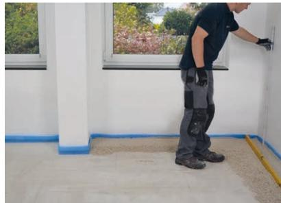
Dämme anhand des Meterrisses im Höhenprofil ausbilden. Schichtstärke mind. 30 mm bis max. 500 mm.
