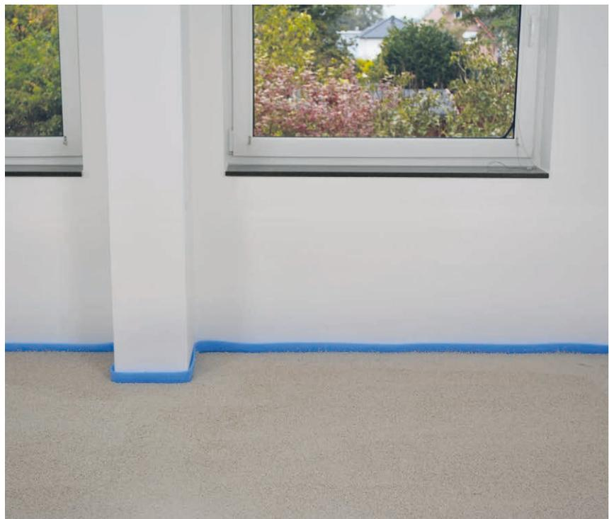
Nach 12 Stunden Trocknungszeit ist die Fläche begehbar und nach 3 – 4 Tagen belegbar. Achtung: CompactFloor THERM CE ist keine fertige Nutzschicht zur direkten Aufnahme von Bodenbelägen.
