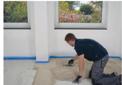
Fläche zwischen den Dämmen auffüllen und mit Kelle klopfend verdichten.
