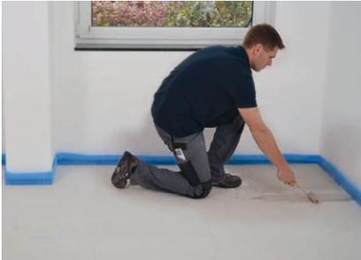
Randdämmstreifen auslegen, Untergrund sorgfältig reinigen und für eine ausreichende Haftung mit Tiefgrund grundieren.
