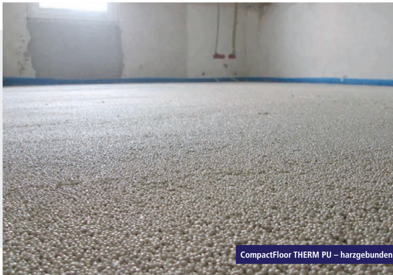
Wärmedämmender Höhenausgleich
