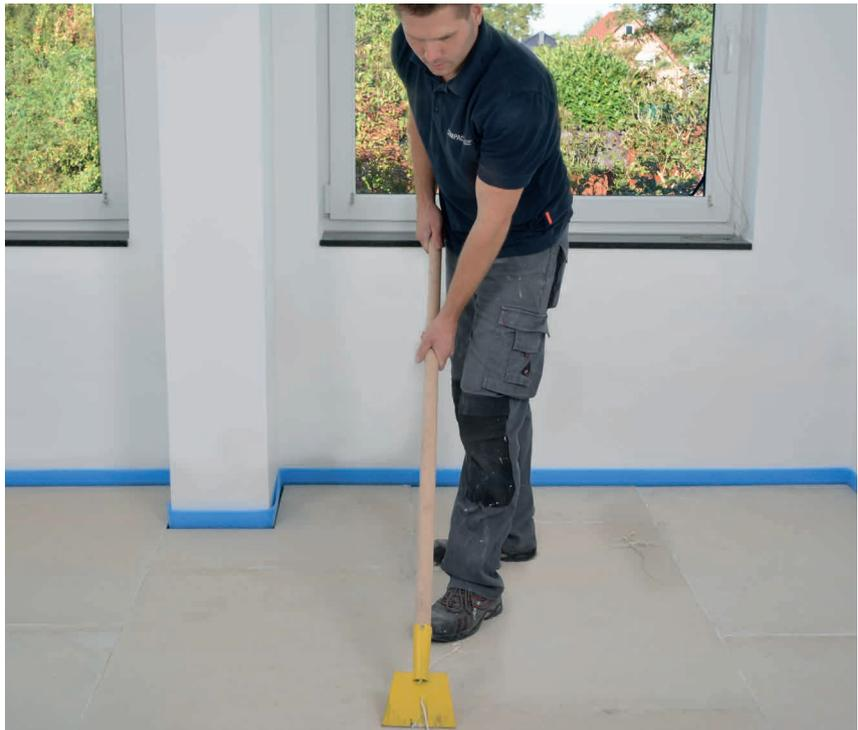
Nach 24 Stunden Trocknungszeit lässt sich der überschüssige Kleber mit einem Spachtel entfernen. Anschließend kann der Bodenbelag verlegt werden (Beachten Sie unsere Freigaben → Datenblätter Bodenbeläge | Kleber).
