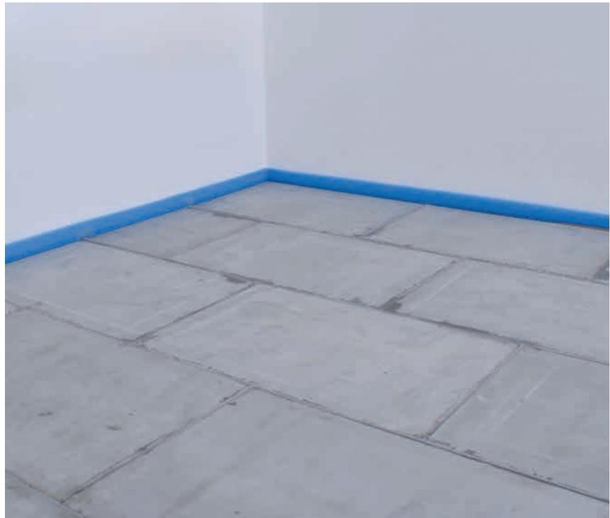
Nach 24 Stunden Trocknungszeit ist CompactFloor EXPERT 20 begeh- und belegbar. Alle Bodenbeläge können verlegt werden.
