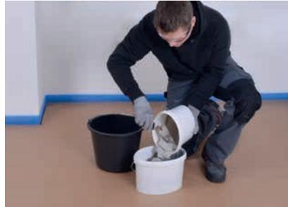
Komponente B (2 kg) in Komponente A (4 kg) geben und vollständig verrühren. Schutzbrille und Handschuhe tragen.
