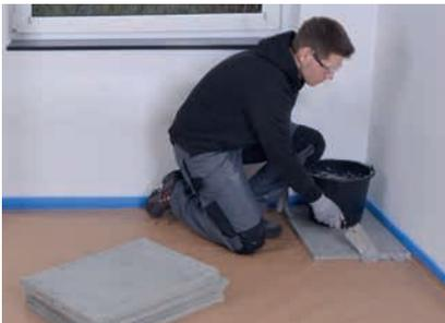
Epoxikleber entlang der Stoßkante mit einer Kelle auftragen und nächstes Element fest anschieben. Fugenbreite mind. 2 mm.
