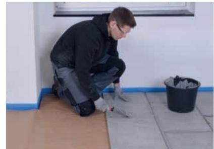
Herausquillenden Kleber unmittelbar abziehen und für die nächste Stoßkante verwenden.
