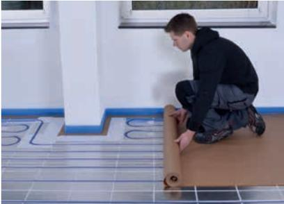
Geeignete druckstabile Trockenbau-Fußbodenheizung verlegen und Trennlage (Folie) darauf überlappend ausrollen.
