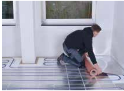
CompactFloor DIRECT ausrollen und Stoßkanten mit Aluminiumklebeband verkleben
