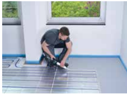
CompactFloor PRO Elemente am Stufenfalz verkleben
