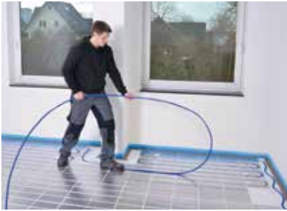
Geeignete druckstabile Trockenbau-Fußbodenheizung verlegen
