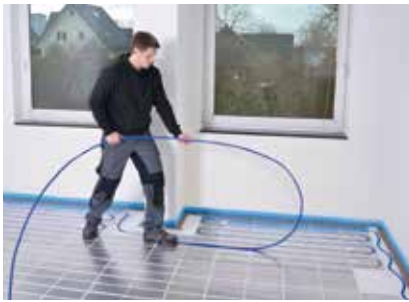
Geeignete druckstabile Trockenbau-Fußbodenheizung verlegen
