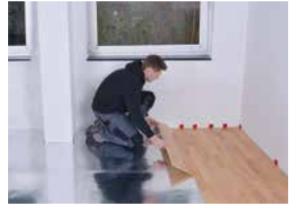
Geeignetes Parkett nach Herstellerangaben schwimmend verlegen
