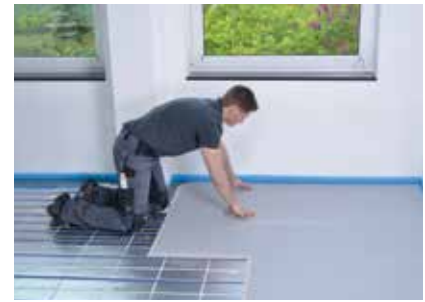
Elemente fest andrücken und überschüssigen, getrockneten Kleber entfernen
