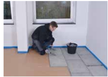
CompactFloor EXPERT verlegen und dabei die Stoßkanten verkleben
