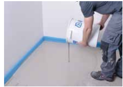
CompactFloor LIQUID Tragschicht in ca. 8 bis 9 mm Höhe einbringen
