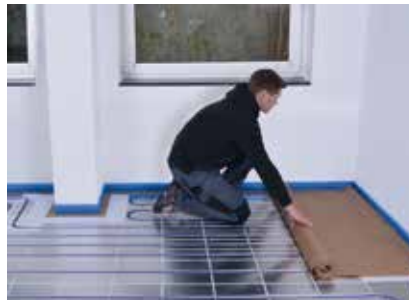
Trennlage (Folie) im Raum ausrollen und überlappend verlegen
