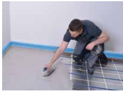
CompactFloor LIQUID Kontaktschicht mit einer Kelle dünn auftragen
